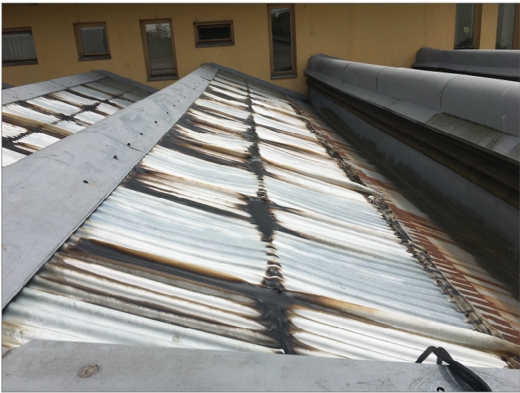
pohled na poškozenou střechu s laminátovými deskami
